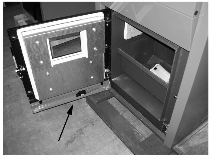
Abbildung 21: Brennerstecker in der Türverkleidung
