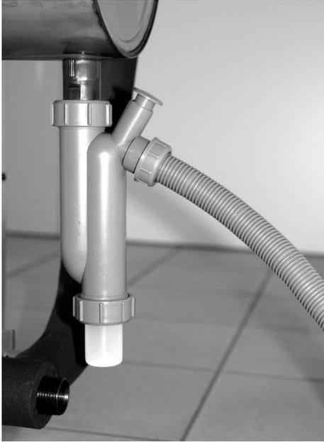
2. Siphon und Kondensatleitung demontieren und spülen
