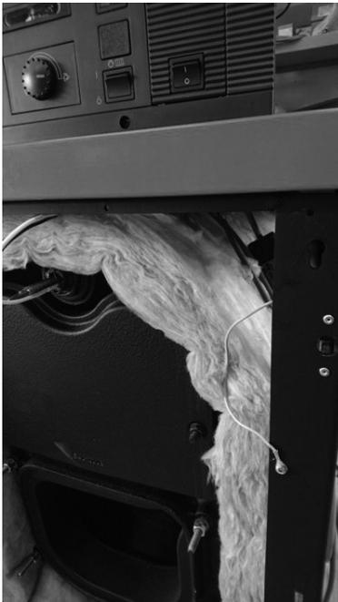
6.) Das Brennerkabel mit Brennerstecker seitlich nach unten führen und nach vorne 30 cm herausziehen.
