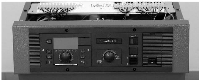
Abb. 24: THETA+ Regelung mit zwei Schrauben befestigen.
