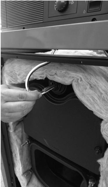
4.) Die 3 Fühler für das Kesselthermometer, das Kesselthermostat und den Kesselsicherheitstemperaturbegrenzer in die dafür vorgesehene Tauchhülse stecken und fixieren.
