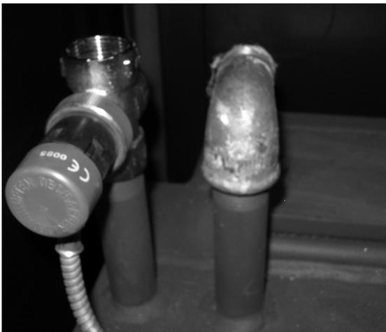
Abb. 3: Thermische Ablaufsicherung, Montage im Kessel
