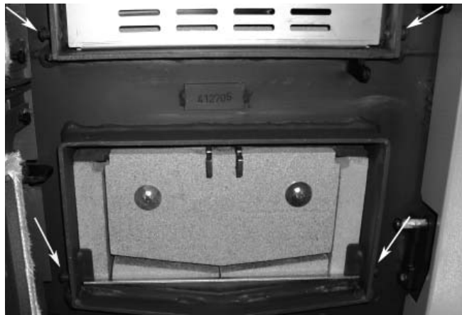
Abb. 30: Aschekasten nach vorn gezogen. Pfeile: Bolzen zur Aufhängung der Ascheauffanglade
