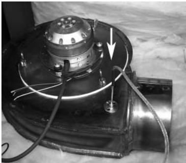
Abb. 25: Der Abgasfühler
