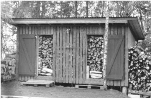
Abb. 26: Das richtige Holzlager
