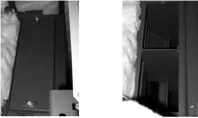
Abb. 38/39: Der Reinigungsdeckel und die Steigzüge
