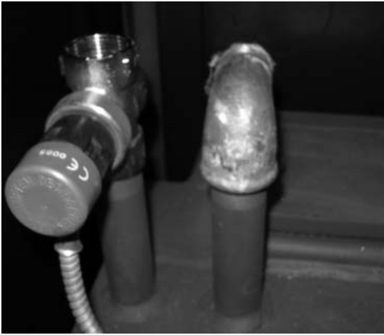
Abb. 3: Thermische Ablaufsicherung, Montage im Kessel
