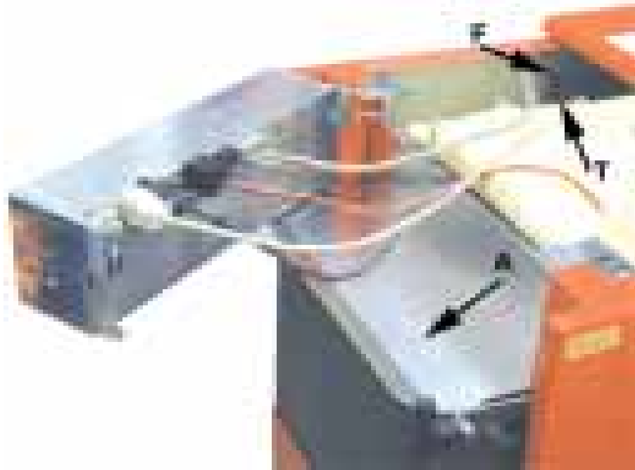
Abb.8-1: Montageplatz für das Schaltfeld am Kessel
